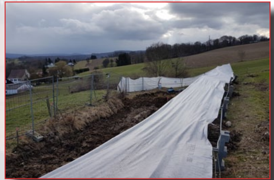
Billigsanierung in Hagenthal-le-Bas 07.03.2017 / Bild: PP
